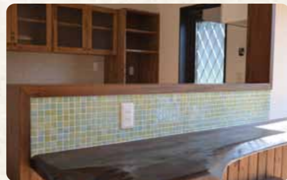
●天然木の一枚板を加工して作り、モザイクタイルでおしゃれに仕上げた対面カウンター。後ろに見える食器棚はオーダーメイドの一品物です。
