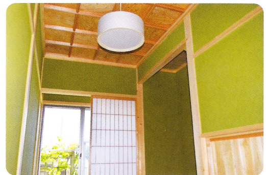
●和室の天井は格天井という工法で仕上げ、 重厚感のある骨組のマスの中には腰板と同じく ウズクリ加工された杉の板で仕上げました。
